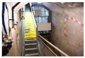
Die Festung ist nicht auf einer Ebene, sondern es gilt einige Höhendifferenzen zu überwinden. Um die Munition zu den Geschützen hochzufahren, wurde eine Mat Seilbahn errichtet, welche 80 Meter die Lasten in die Höhe hievte. Nun dient die 2012 erneuerte Bahn dem Personentransport und als Besucher genossen wir die kurze Fahrt im Stollen. Allerdings Metro-Gefühle wie in einer Grossstadt konnten im offenen Bahnwagen nicht aufkommen.
